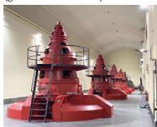
Innertkirchen 1 ist eines der wichtigsten Kraftwerke der KWO. Es bildet den Abschluss der Kraftwerksketten im Aaretal. Das Kraftwerk verfügt über eine sehr grosse Leistung und erzeugt damit vor allem Spitzen- und Regulierenergie. Die 5 Pelonturbinen produzieren zusammen 240 Megawatt Strom (Nettoleistung). Die neuere Pelton-turbine in Innertkirchen 1 E produziert 154 Megawatt (Nettoleistung).
